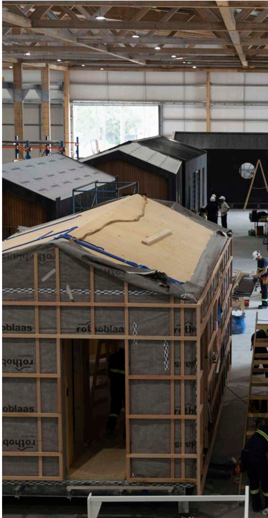
Nueva planta de viviendas modulares en El Pinar.
